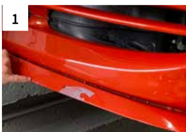
1 Schadstelle reinigen mit
